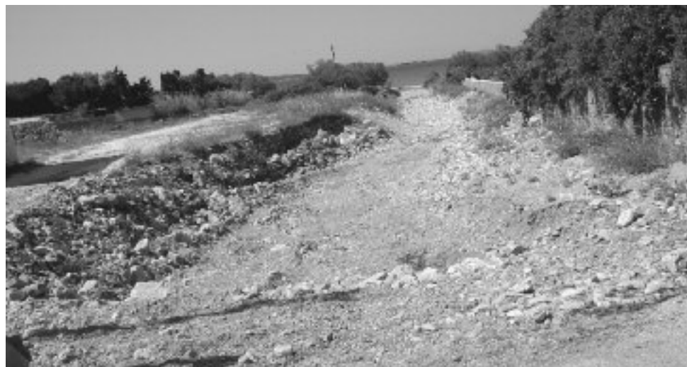
Υπό κατασκευή αντιπλημμυρικό έργο στην Αλυκή
